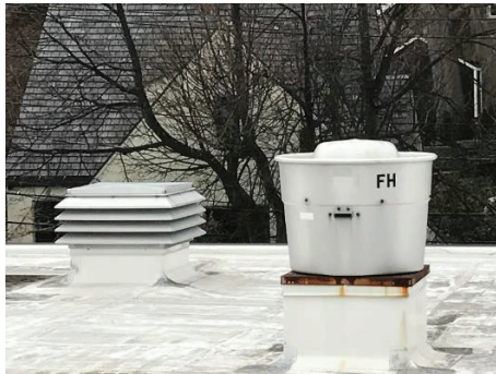
Roof Fume Hood Exhaust Fan
