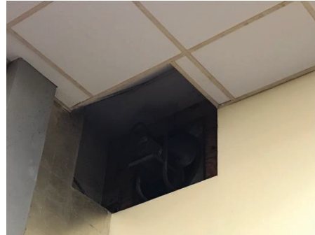
Wall Propeller Exhaust Fan
